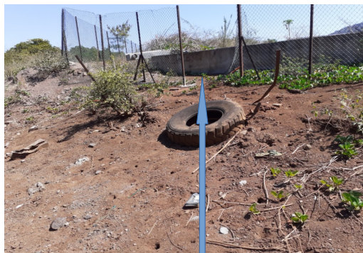
Clôture à réparer
