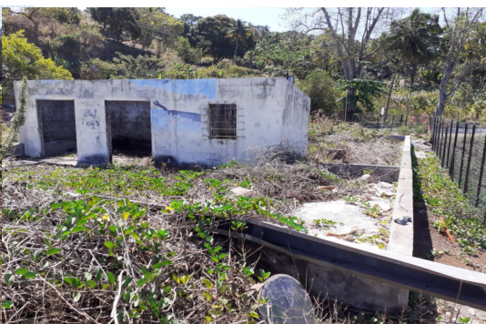
Bâtiment à démolir
